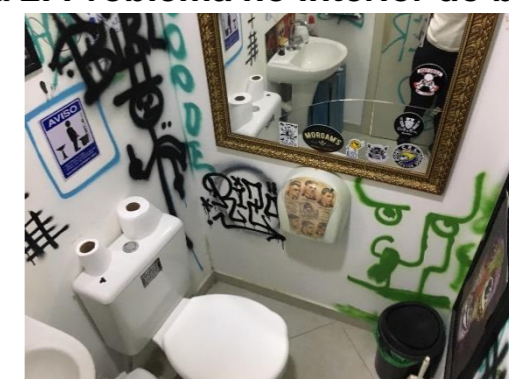
Figura 2. Problema no interior do banheiro
